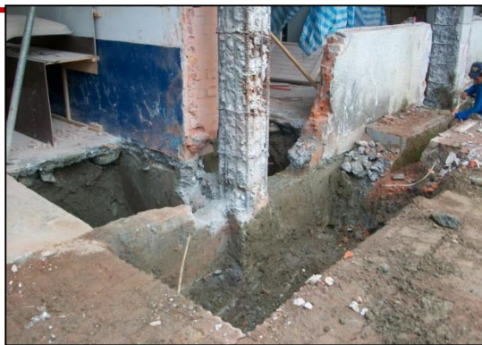
補強處基礎開挖
