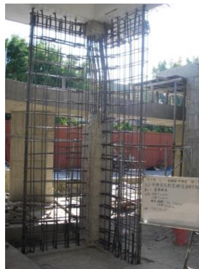
鑽孔植入 牆筋
