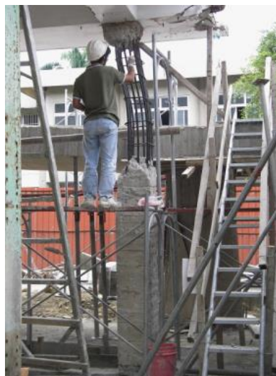
碎裂混凝土 清除
