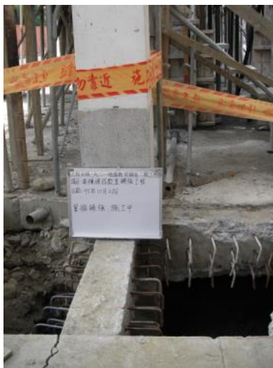
補強處基礎 開挖
